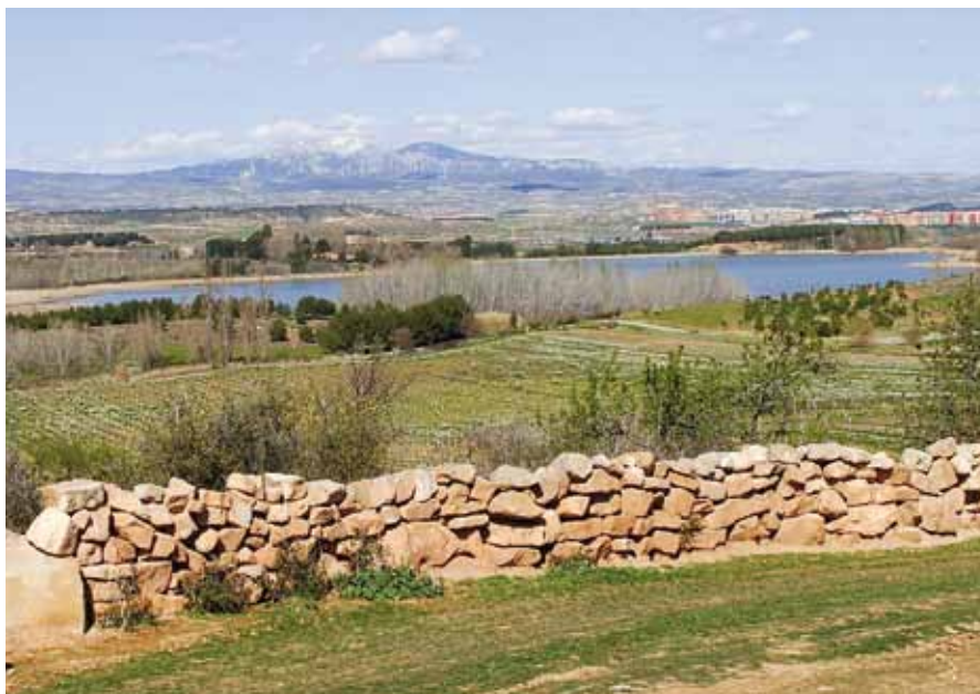
Murete de piedra construido en el contexto del proyecto BioDiVine.
